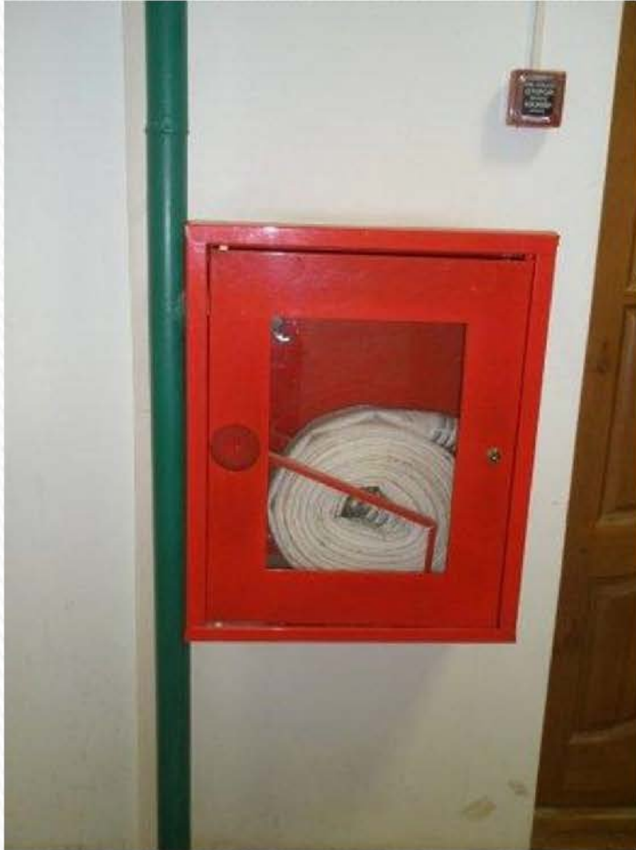
Fire safety hydrants/ Гидранты пожарные безопасности
